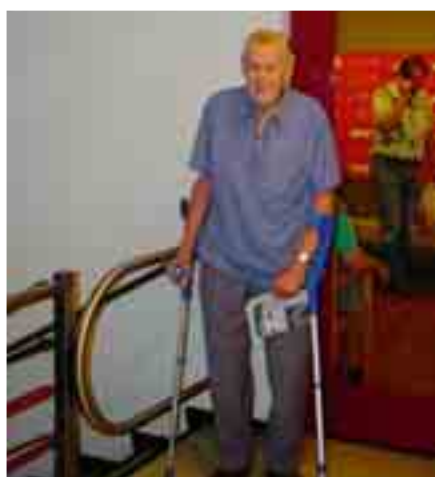
Un étrier de protection empêche les chutes en arrière
