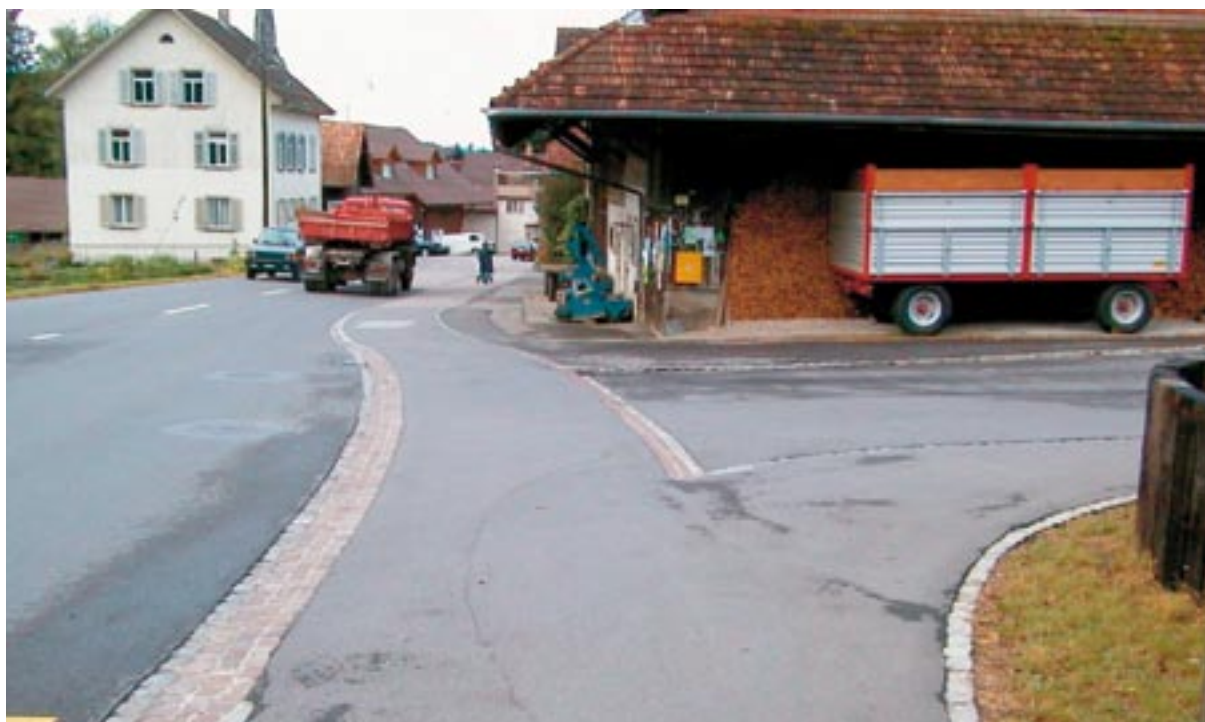
Immagine 9 Marciapiede continuo
