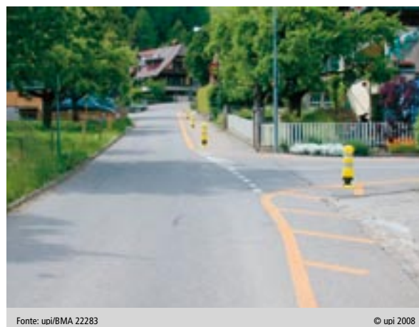
Immagine 8 Paletti di sicurezza su una corsia pedonale
