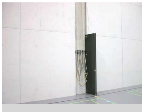
Immagine 13 Copertura montata in secondo tempo e fissata con chiusura a velcro
