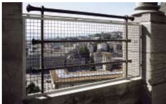
All'esterno, alcuni pannelli a griglia garantiscono la sicurezza delle aperture, situate a un'altezza di quasi 40 metri.
