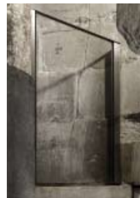
La posa dei parapetti ha richiesto l'uso di ponteggi e palanchi.
