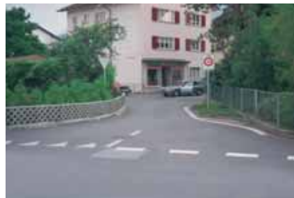
Torelement zu Beginn der Tempo-30-Zone
