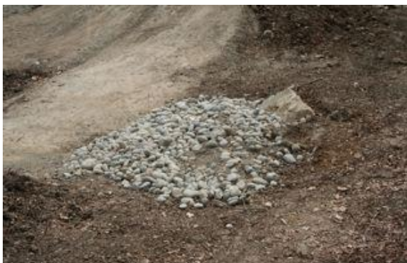
Abbildung 4 Drainage im Kiesbett
