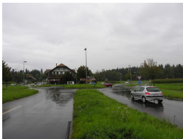
Source: bpa Jonction A6/RC6 à Kiesen (BE) après le 1.1.97
