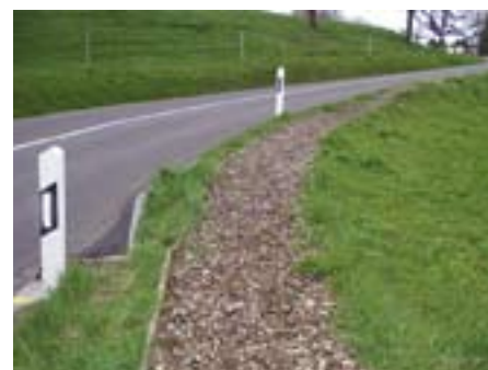
Un trajet scolaire sûr grâce à un nouveau chemin de terre.
